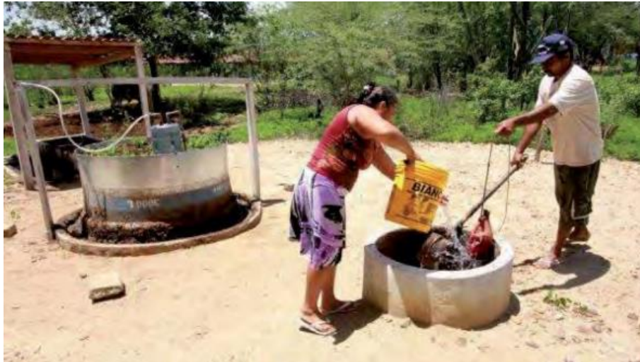
Figura 8 – Biodigestor Modelo Sertanejo. Fonte: MATTOS e FARIA JÚNIOR (2011).
